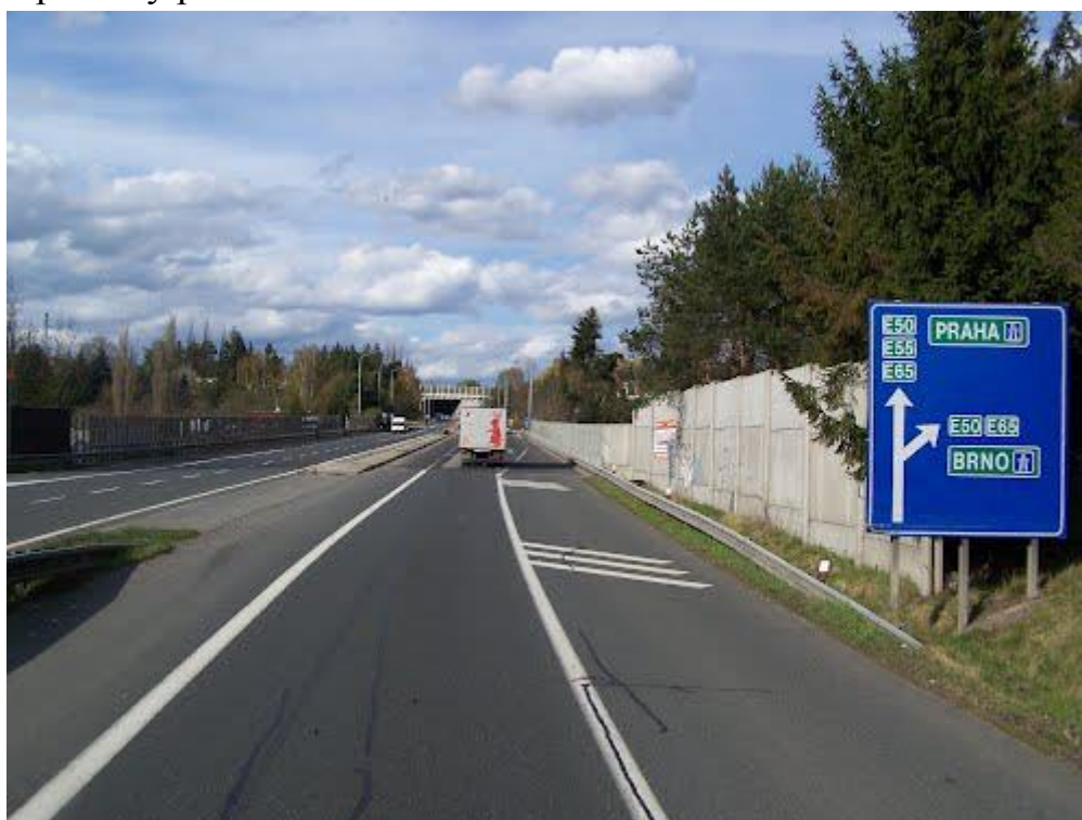
Opravený přivaděč I/3 u Mirošovic
