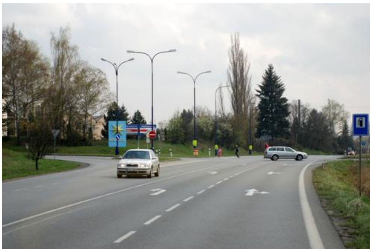
Opravený přivaděč I/3 u Benešova
